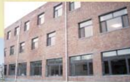
三層多功能樓房
