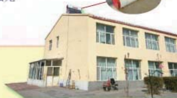
在屋頂架設太陽能熱水器裝置
