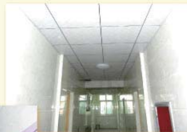
天花和病房走廊完成裝修
