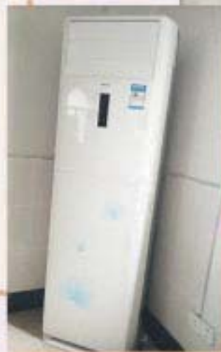
安裝空調系統
