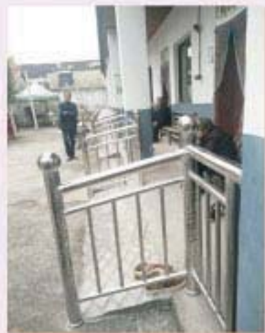
在通道和浴間安裝扶手
