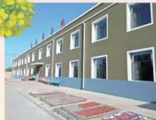
院舍外牆保溫層完成覆蓋
